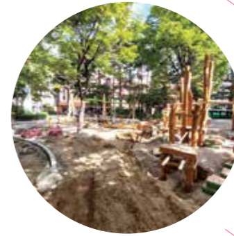
놀이시설물 설치 공사
