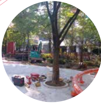
운동시설 이설 / 휴게시설 설치
