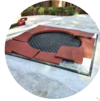
고무칩 및 바닥포장 공사
