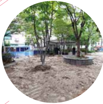
포장 철거 및 부지 정리
