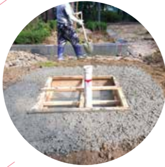
경계석 설치 / 음수전 이전 공사
