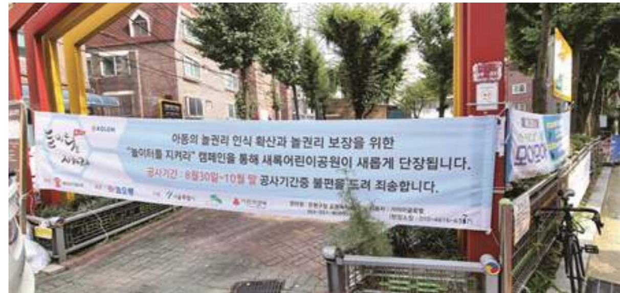
공원 리모델링 공사 진행 알림 및 접근방지
