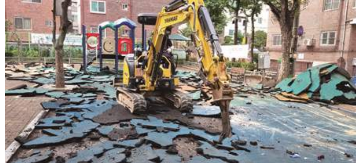
시설물 철거 / 폐기물 처리
